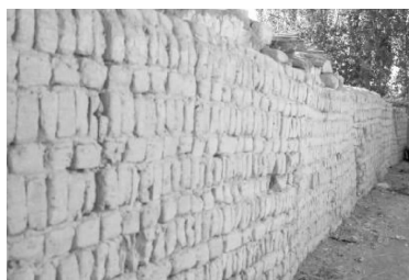
图11 干垒法垒建的墙体
