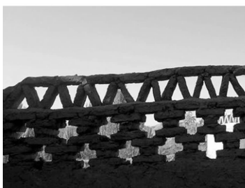
图10 湿垒法建造的墙体
