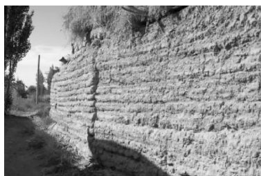
图10 湿垒法建造的墙体
