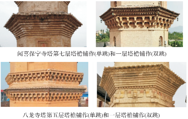
图 9 塔檐铺作上下层减跳做法示例
