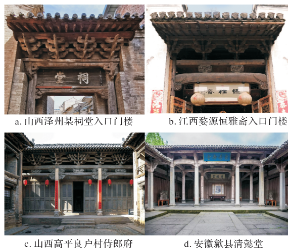
图2 南北方不同的阑额月梁造
