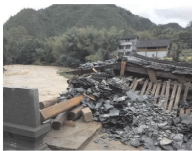
图2 被洪水冲垮的文重桥
